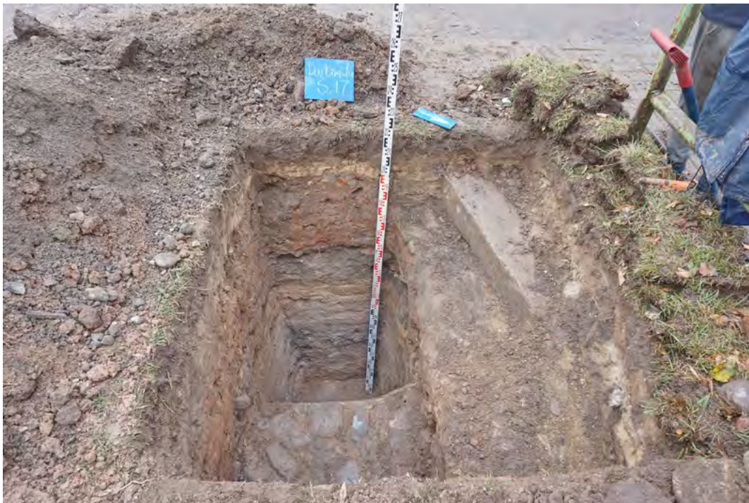
Šurfas Nr. 17, PV sienelė. Gylis 2,25 m (fotografuota iš ŠR)
