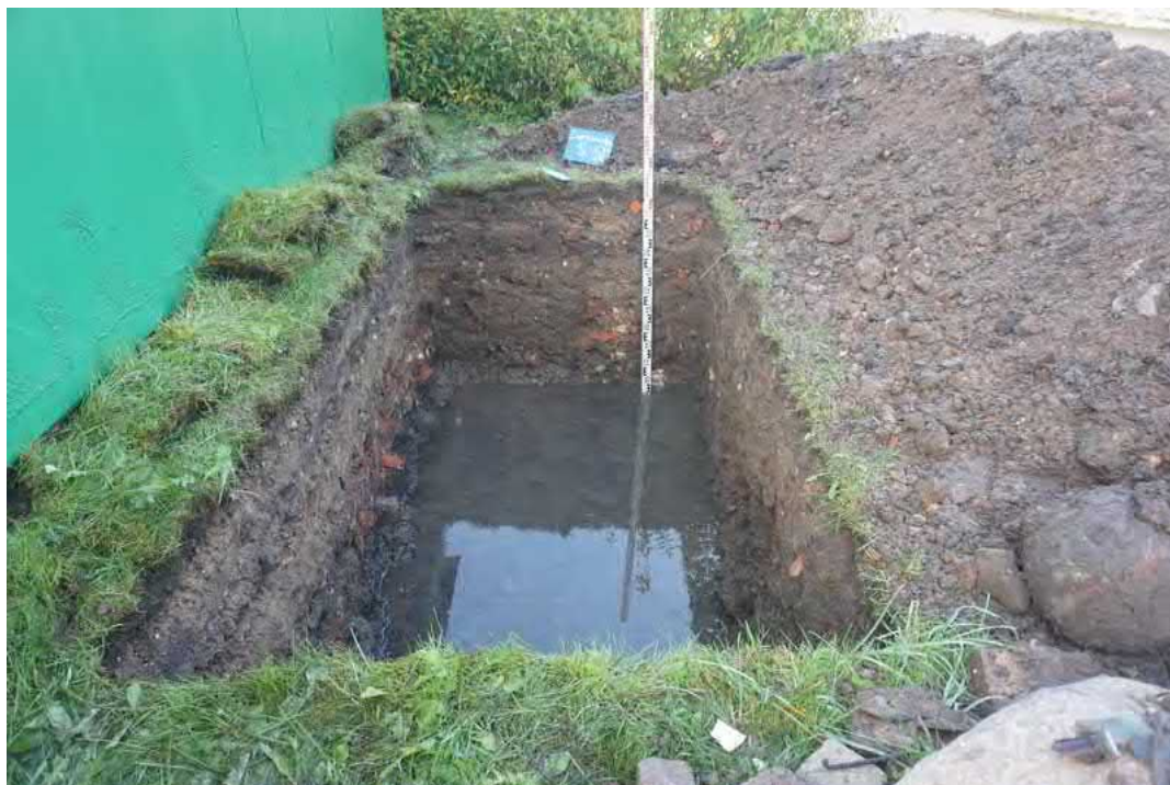
Šurfas Nr. 9, PV sienelė. Gylis 1,2 m (fotografuota iš ŠR)
